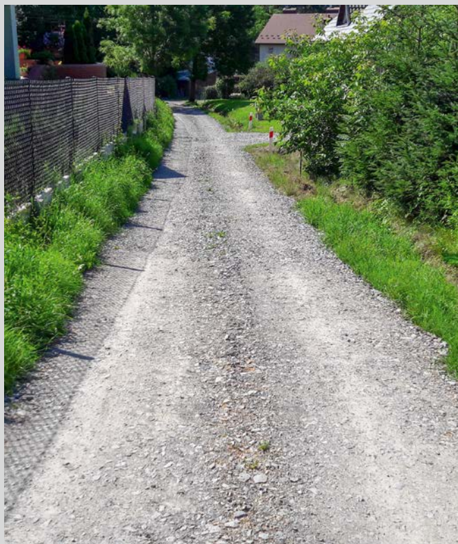
Droga 3168 przed robotami
