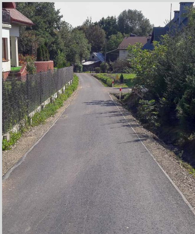
Droga 3168 po robotach
