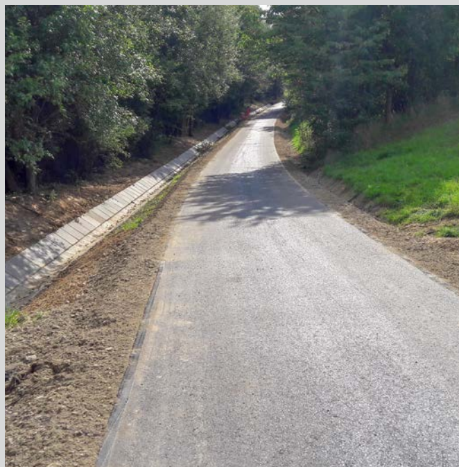
Droga ul. Głęboka po robotach
